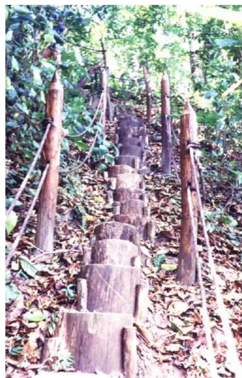
Figura 251 - Escadas feitas com tocos de madeira em áreas com aclive acentuado no Parque Nacional de Ubajara - CE.
