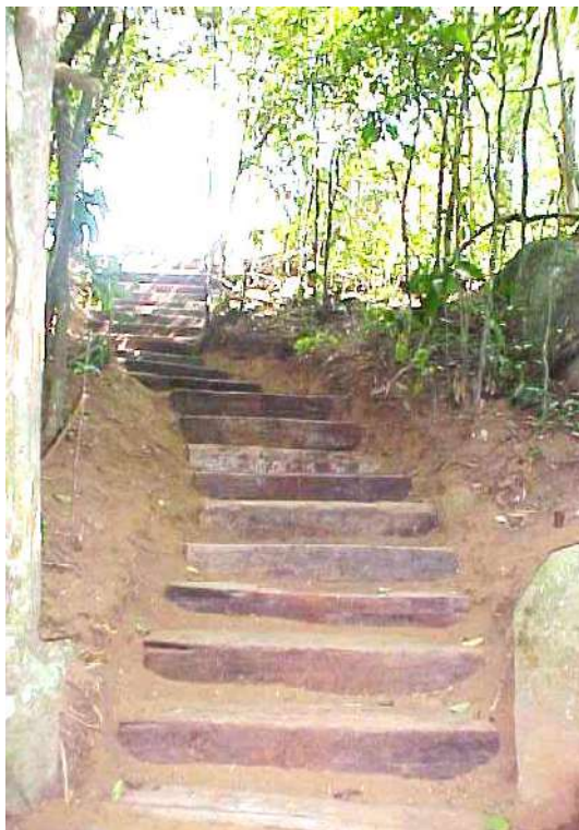
Figura 250 - Escadas feitas com dormente em áreas com aclive acentuado no Parque Estadual da Fonte Grande.
