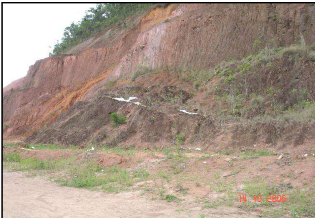
Figura 60: Deslizamento de talude, devido a fortes chuvas ocorridas, durante as campanhas de campo.
