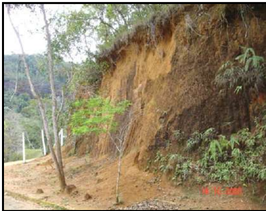
Figura 58: Deslizamento de talude, devido a fortes chuvas ocorridas, durante as campanhas de campo. Foto: Lênio B. da Silva.
