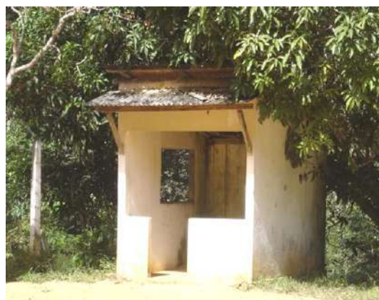
Figura 182 – Guarita abandonada localizada ao lado do portal de acesso a area da Cachoeira do Country Club.
