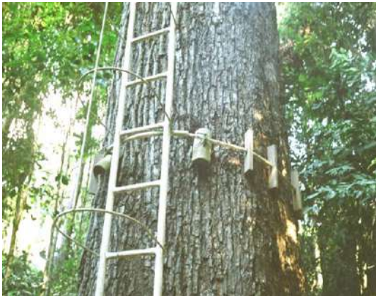
Figura 199 – Escada de acesso ao mirante de madeira instalado sobre um jequitibá centenário, fixada por cabos de aço ajustáveis, apoiados em calços de madeira.
