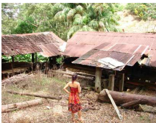
Figura 164 - Vista geral da serraria movida antigamente a água. Foto: Edson Valpassos
