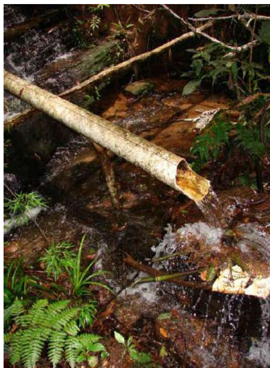
Figura 206 - Captação de água de nascente dentro da area “A”, acima da Cach. da Greta. Foto: Edson Valpassos
