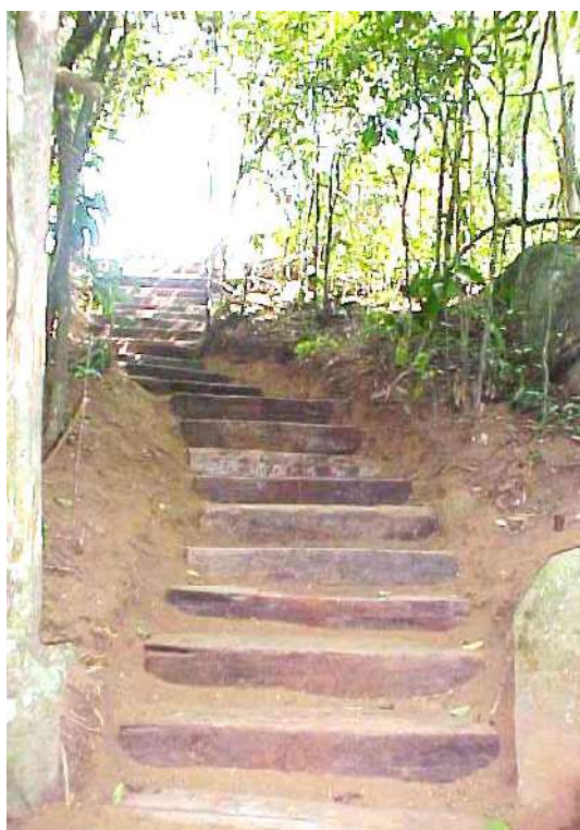
Figura 250 - Escadas feitas com dormente em áreas com aclave acentuada no Parque Estadual da Fonte Grande.
