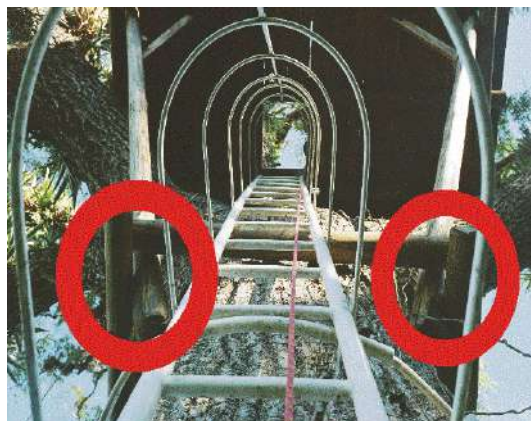
Figura 200 – Destaque para o sistema de fixação do mirante de madeira instalado sobre o jequitibá centenário sem uso de pregos, parafusos ou vergalhões.
