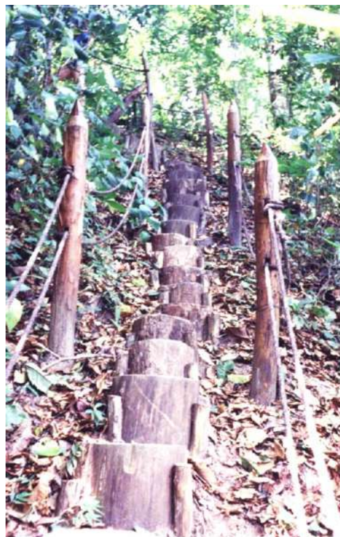
Figura 251 - Escadas feitas com tocos de madeira em áreas com aclave acentuada no Parque Nacional de Ubajara - CE.
